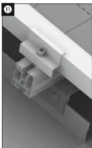
Figura 3 – Fixação dos módulos fotovoltaicos por pressão
